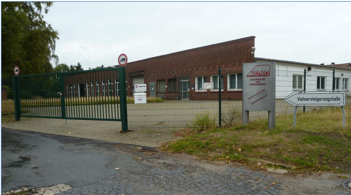
Abbildung 45: Eingangsbereich zu den Gewerbehallen der „NORO GmbH“ vor Beginn des Rückbaus.
