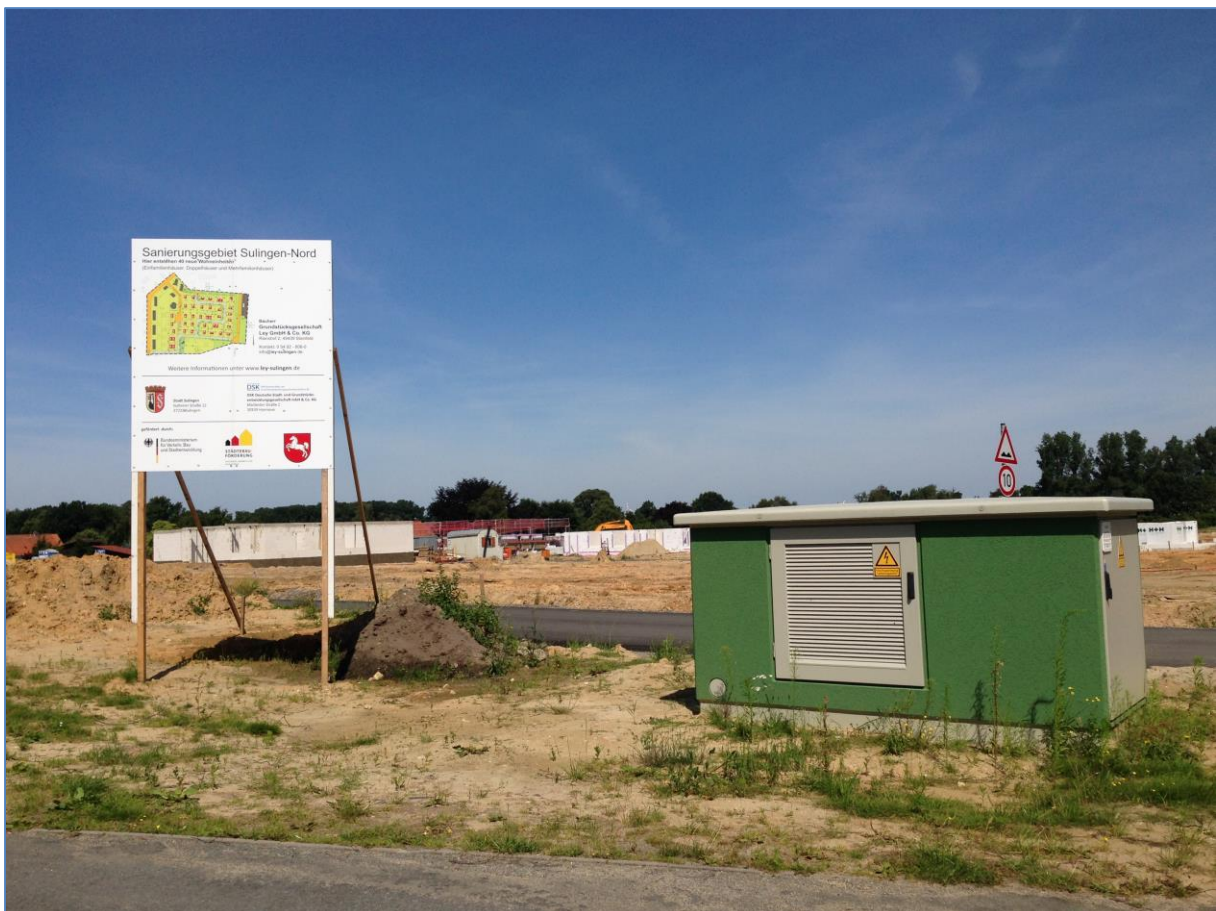
Abbildung 24: Der Bereich des B-Plan 83 „Hinterm Wolfsbaum“ zu Beginn der Erschließungsmaßnahme.
