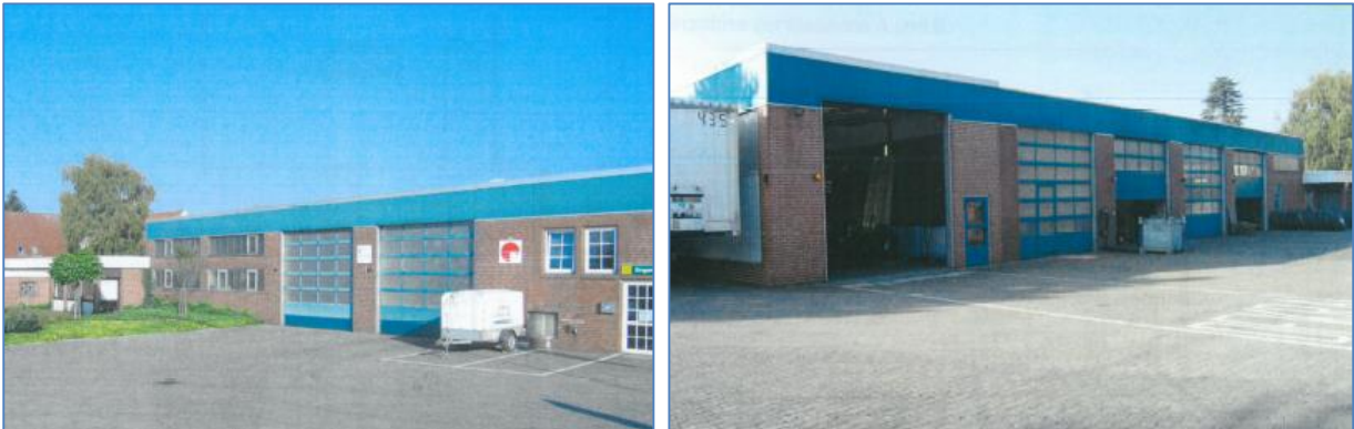
Abbildung 37 und 38: Reparaturhalle der Spedition im „Schwafördener Weg“ 54 von Süden (links) und Norden (rechts) vor der Betriebsverlagerung und dem Rückbau.
