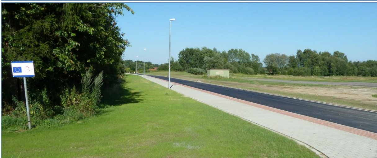
Abbildung 21 und 22: Herstellung des zweiten Bauabschnitts der „Ost-West-Straßenachse“ zu Beginn (oben) und nach Beendigung der Erschließungsmaßnahme.
