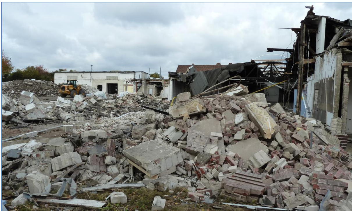
Abbildungen 46 und 47: Rückbau der Gewerbehallen im Jahr 2012.
