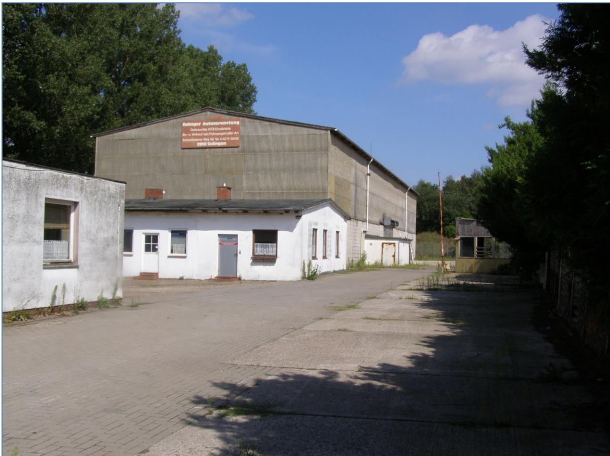
Abbildung 30: Werkhalle, Bürogebäude und Stellplätze der „Sulinger Autoverwertung GmbH“ vor dem Rückbau.
