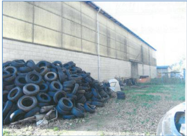
Abbildung 29: Lagerhalle im „Schwafördener Weg“ 48 vor dem Rückbau. Quelle: Verkehrswertgutachten der GAG Sulingen, 2005.
