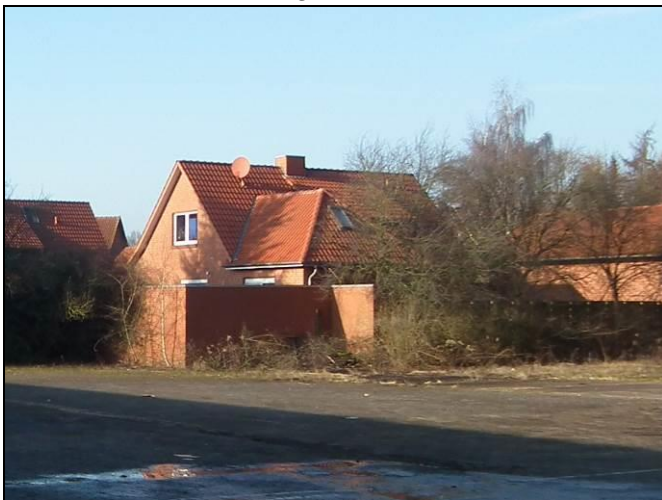
IO5 - Schwaförder Weg 56 - Südostansicht
