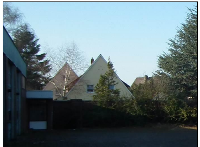
IO6 - Schwaförder Weg 69 - Ostansicht
