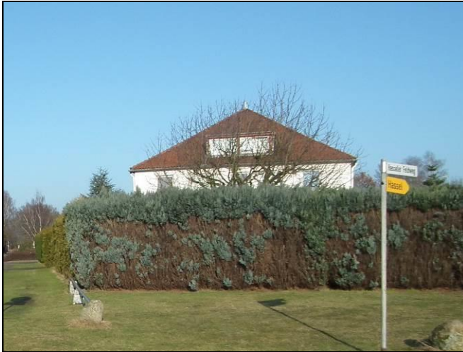
IO7 - Schwaförder Weg 54a - Südwestansicht
