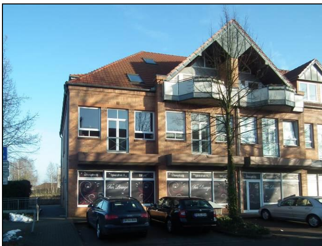
IO17 - Bahnhofstraße 10 - Westansicht
