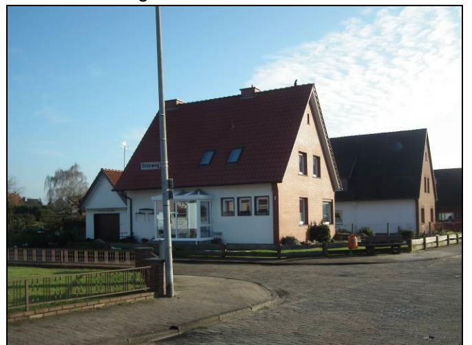
IO18 - Grasweg 2 – Nordwestansicht
