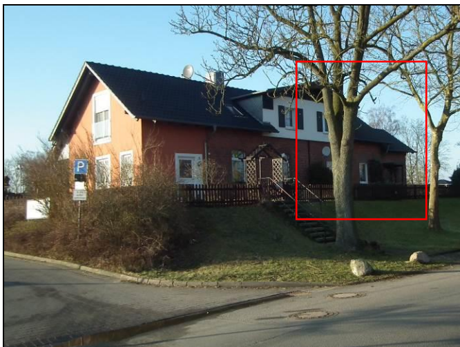
IO15 - Bahnhofstraße 3a - Ostansicht
