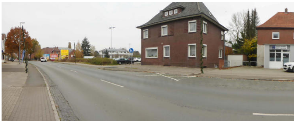
Foto 3: Blick über den Parkplatz zur Bassumer Straße
