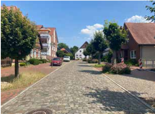
Abb. 41 | Schmiedestraße mit Kopfsteinpflaster
