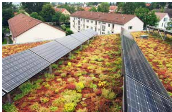
Abb. 89 | Beispiel PV-Anlage mit Dachbegrünung
