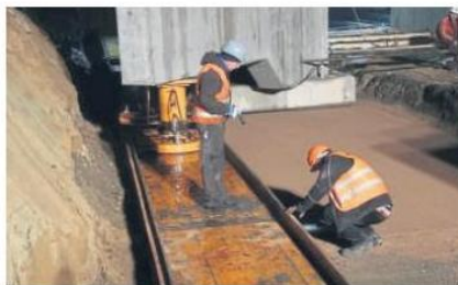
Ständig wurde der Zustand der Schienen kontrolliert.
