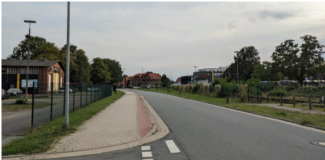
Abbildung 3: Blick entlang der Straße "Am Stellwerk" Richtung Süden
